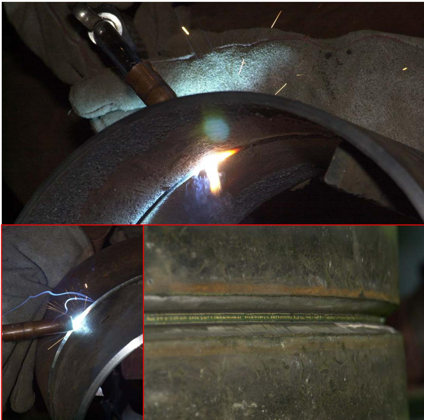
Полное сплавление кромок
